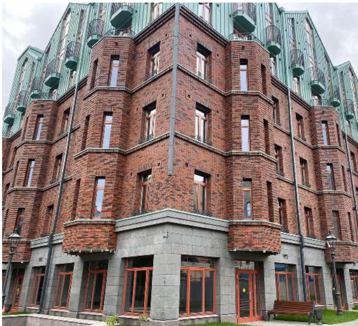
г. Санкт-Петербург, ЖК АртХаус
